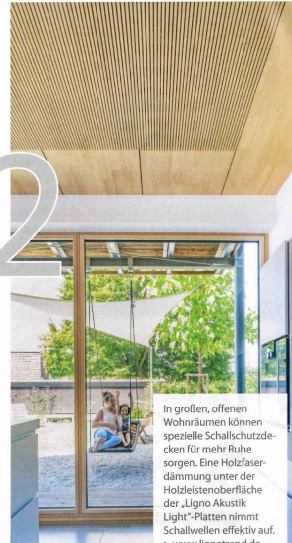
In großen, offenen Wohnräumen können spezielle Schallschutzdecken für mehr Ruhe sorgen. Eine Holzfaserdämmung unter der Holzleistenoberfläche der „Ligno Akustik Light“-Platten nimmt Schallwellen effektiv auf. > [www.lignotrend.de](http://www.lignotrend.de)
